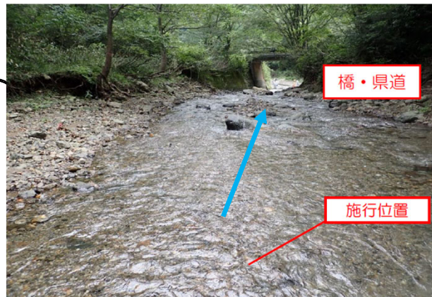
施工位置(大音波川橋付近)
