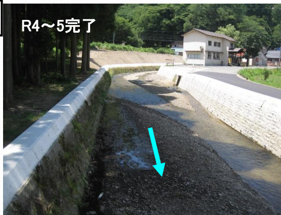
老朽化した護岸の補修工事（余呉町中河内）
