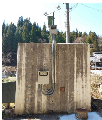
②操作盤移設
