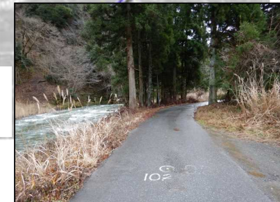
10.2k付近 施工状況 ③
