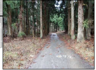
7.2k付近 施工状況 ②
