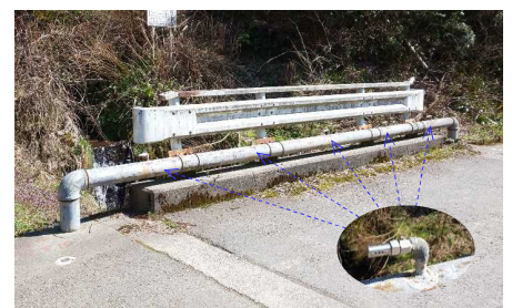
④橋梁部ノズル更新
