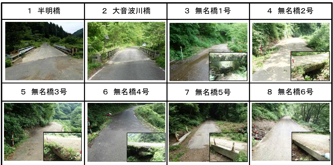
協定区間内橋梁一覧
