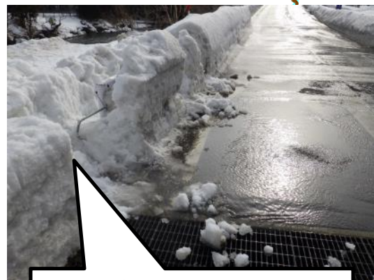
散水ノズル(H30.2月試行設置)
