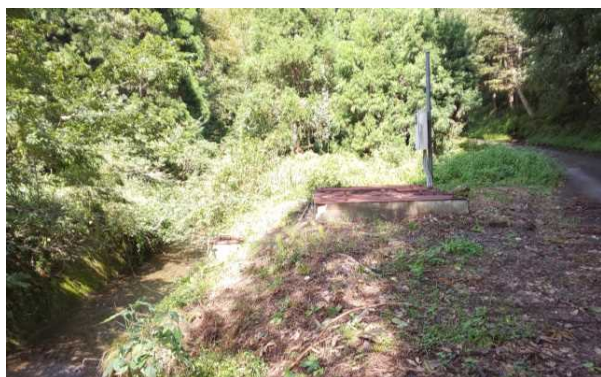
①取水設備
