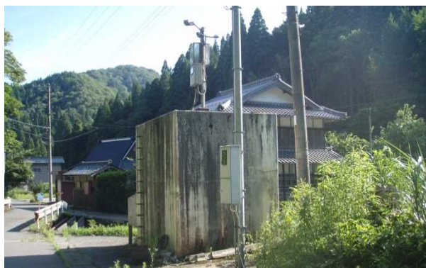
②操作盤移設
