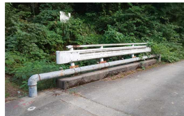
④橋梁部ノズル更新
