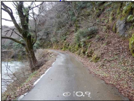
10.9k付近 施工状況 ⑤
