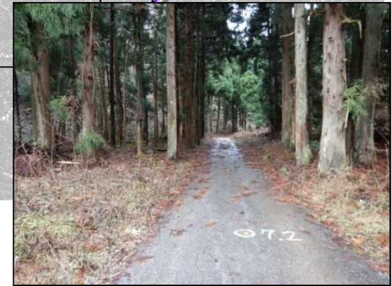
7.2k付近 施工状況 ③
