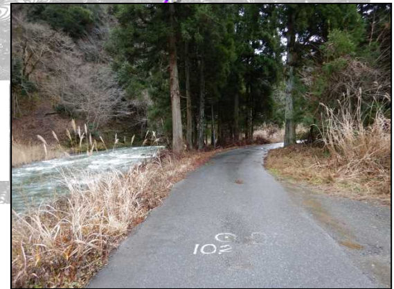
10.2k付近 施工状況 ④
