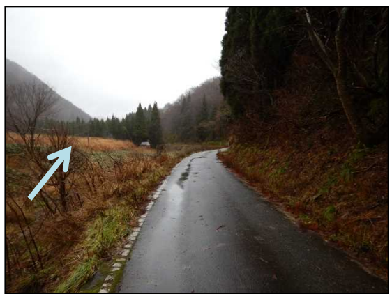
1.7k付近 施工前 ①
