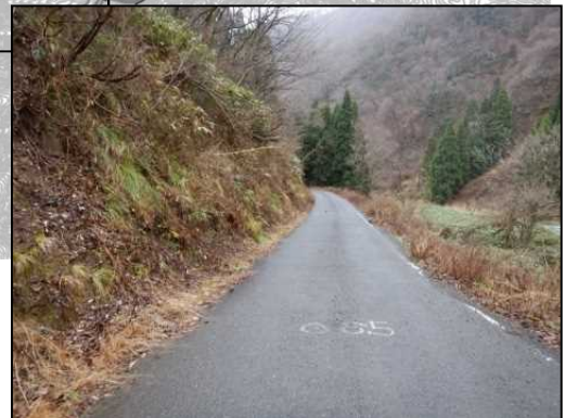
6.5k付近 施工状況 ②
