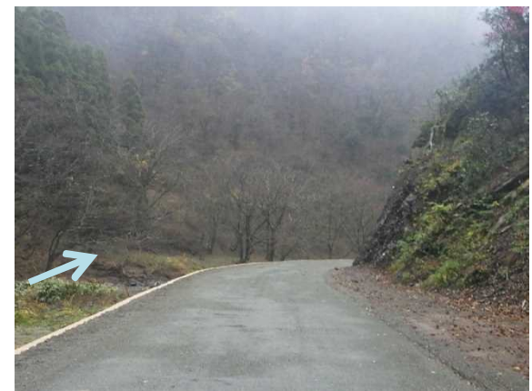
11.8k付近 施工後
