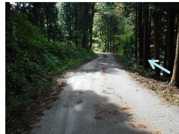
14.9k付近 施工前
