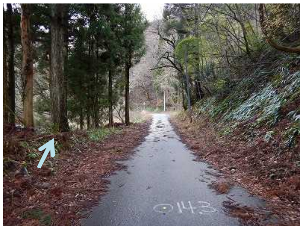
14.3k付近 施工前
