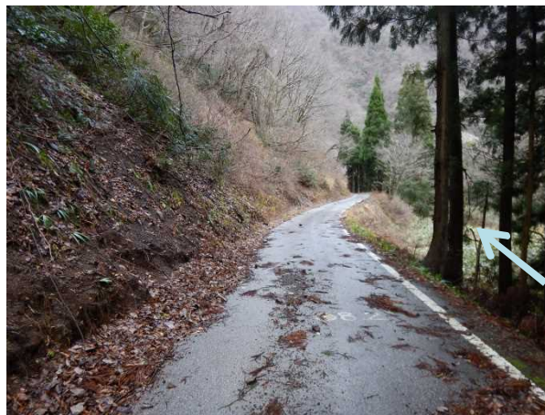
8.2k付近 施工前
