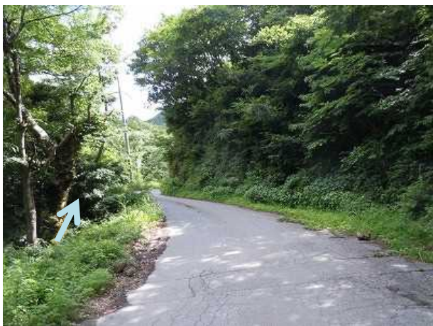
13.3k+60付近 施工前
