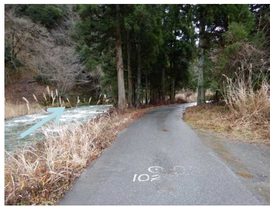
10.2k付近 施工前
