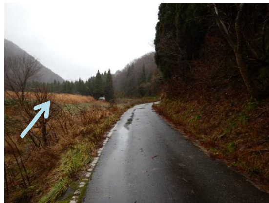
1.7k付近 施工前
