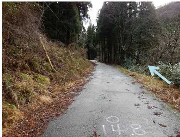
14.8k付近 施工前
