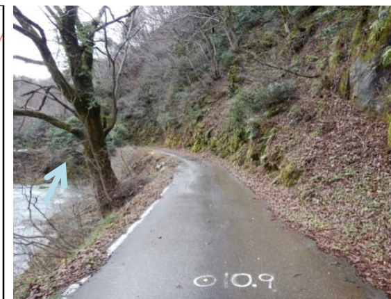
10.9k付近 施工前
