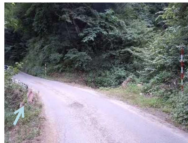
13.8K+36付近 施工前
