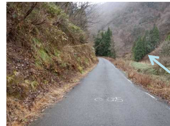
6.5k付近 施工前
