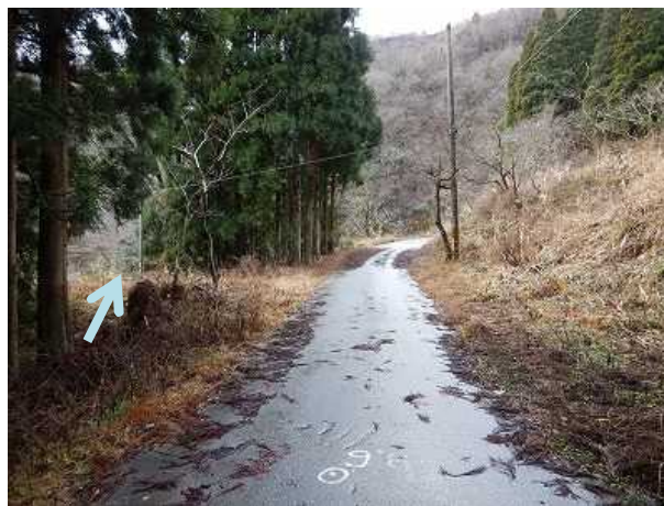
13.6k付近 施工前
