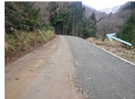
7.0k付近 施工後
