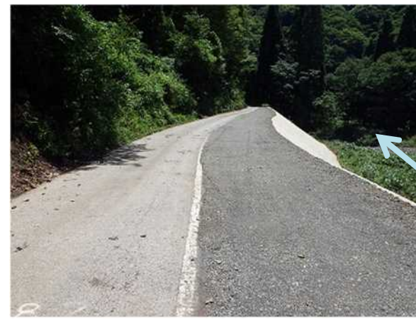
8.2k付近 施工後
