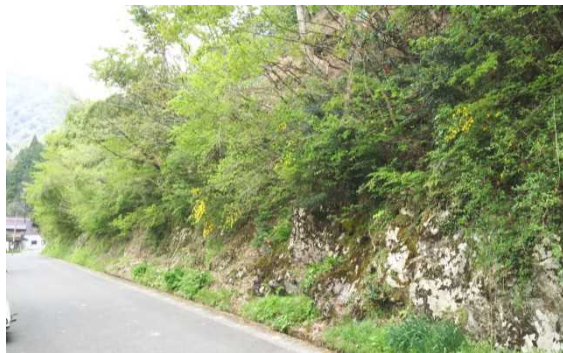
①落石雪崩対策
