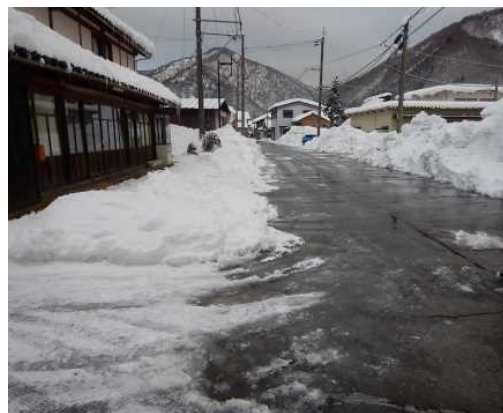
①消雪設備整備
