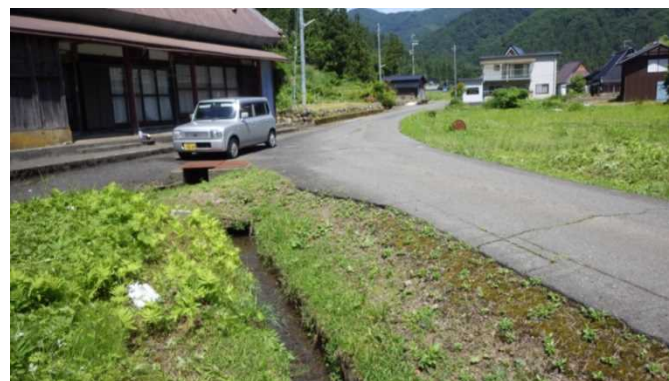
①側溝改修
