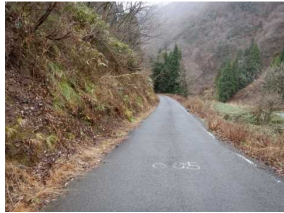
6.5k付近 施工前
