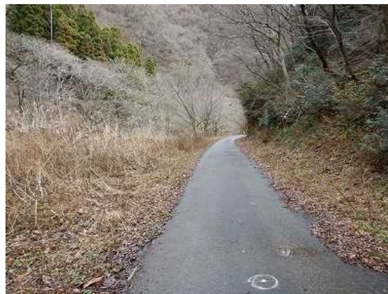
11.8k付近 施工状況
