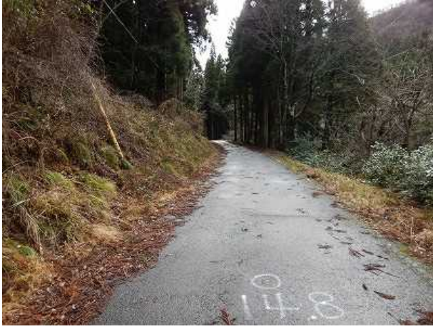
14.8k付近 施工前
