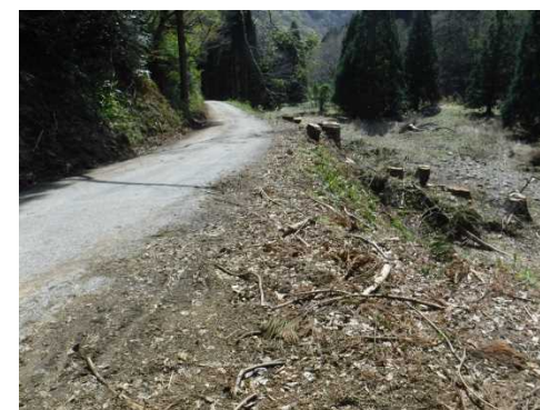
7.0k付近 施工前
