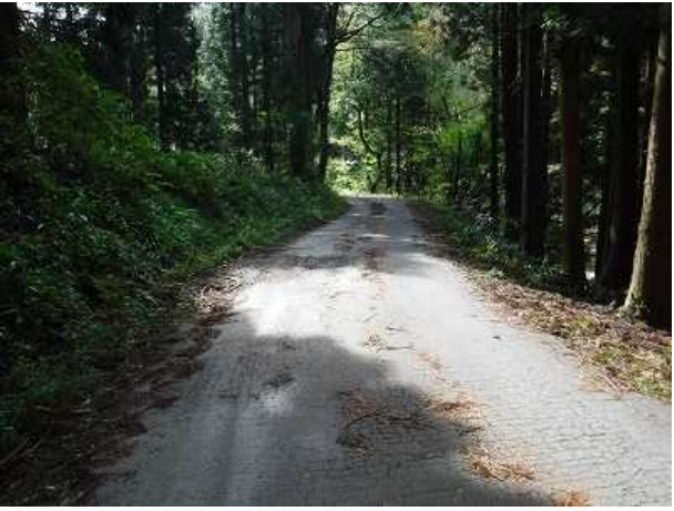
14.9k付近 施工前
