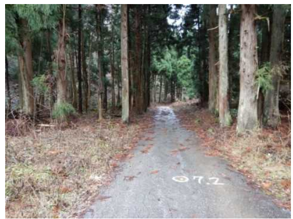
7.2k付近 施工前
