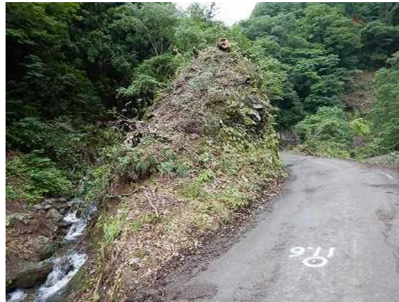
11.6k付近 施工状況
