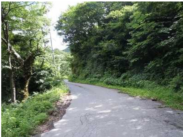
13.3k+60付近 施工前
