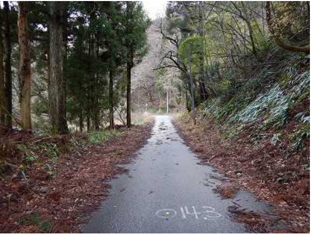
14.3k付近 施工前
