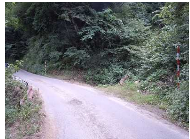
13.8K+36付近 施工前
