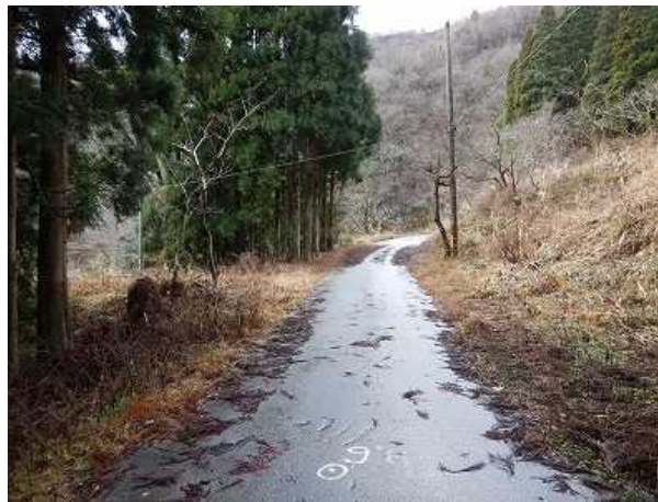
13.6k付近 施工前
