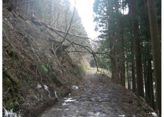
倒木(水没予定地の荒廃状況)
