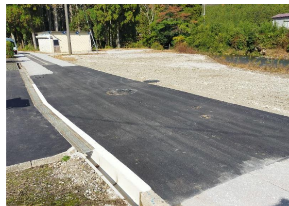
集水井等整備工事完了写真
