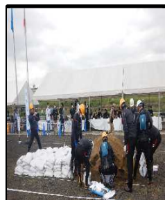
パワーアシスト スーツを活用した 積土のう工
