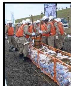
改良越水止め ネット工
