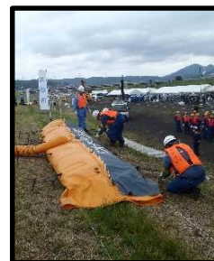
三角水のう工
