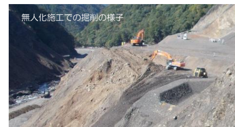
無人化施工での掘削の様子
