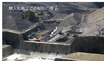
無人化施工での掘削の様子
