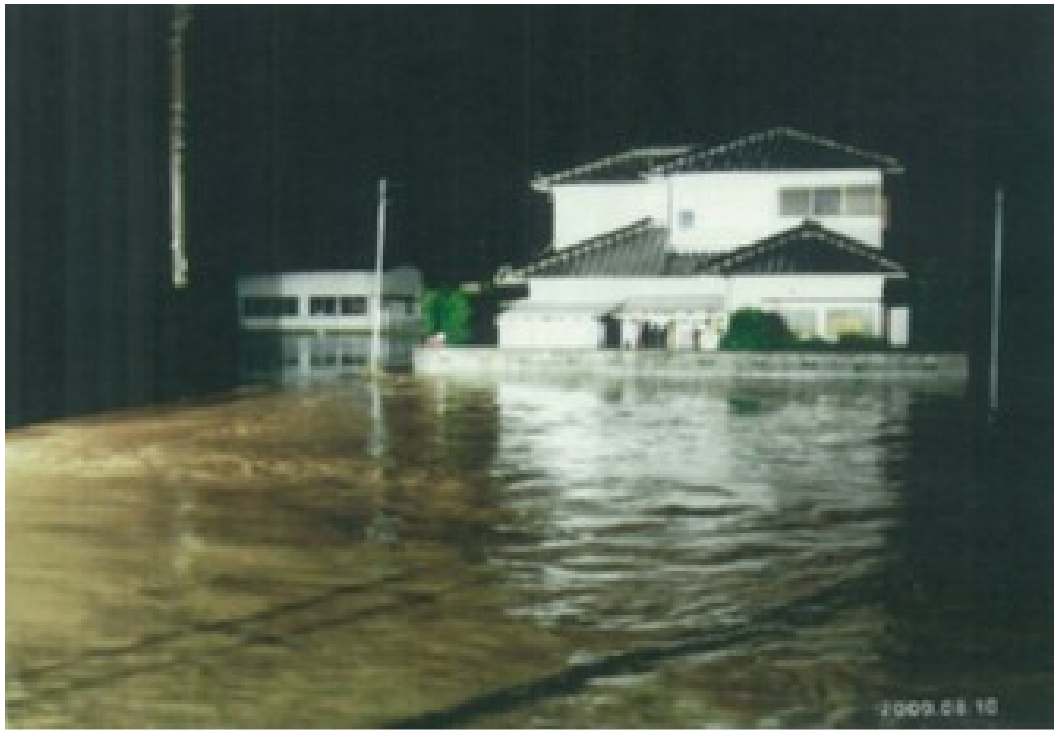
たい 宍粟市田井地区の浸水状況
