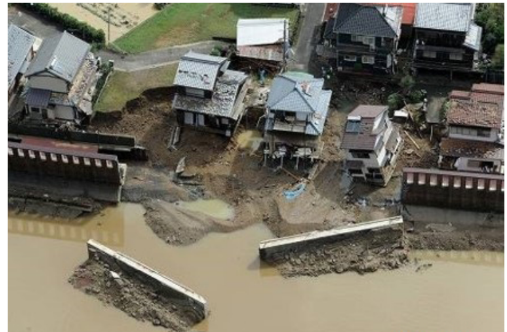
たかおか 倒壊した特殊堤(高岡地区輪中堤)
