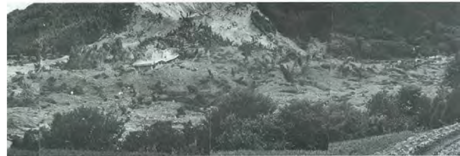
いぼがわ 左岸山崩れにより揖保川が堰き止められた状況 しろうし いちのみやちょうふくち (宍粟市一宮町福知付近)
