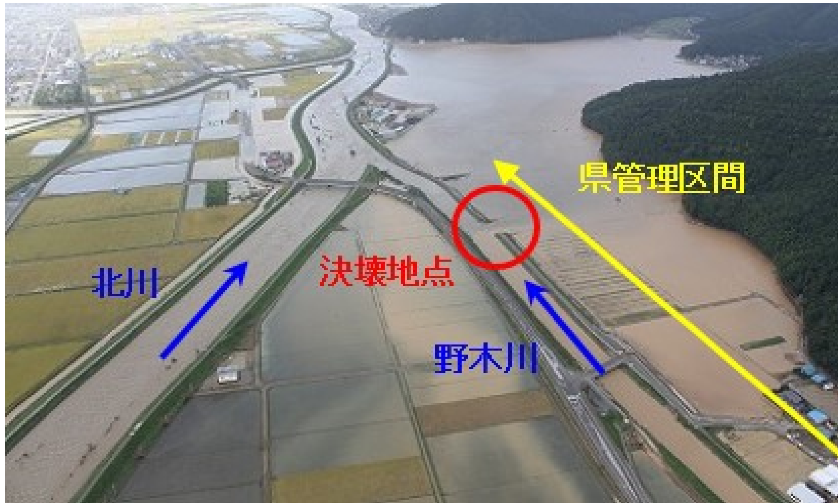
のぎ しものぎ 野木川堤防決壊状況(下野木)
