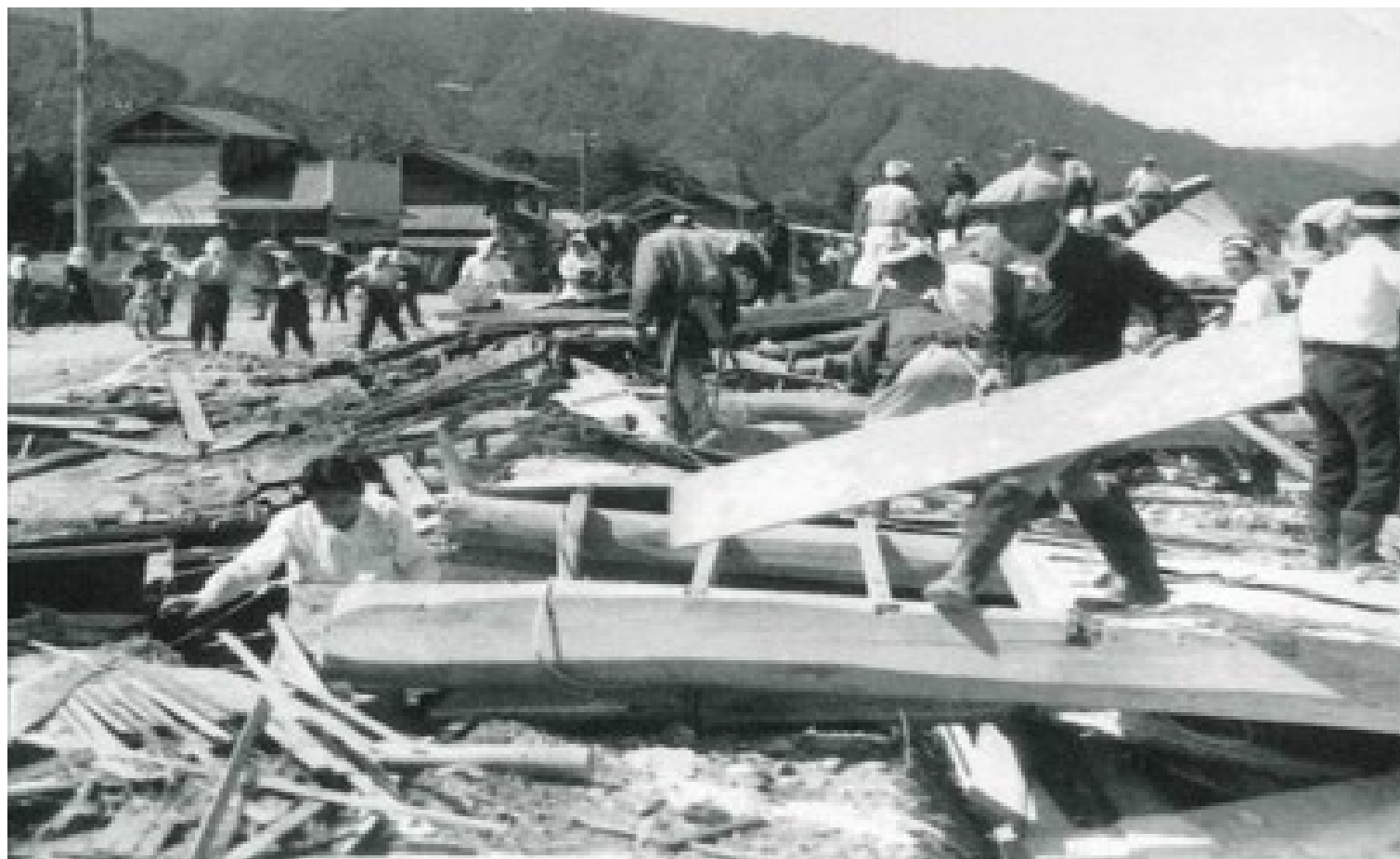
かみしひ えいへいじ 旧上志比村(現永平寺町)の被災状況
