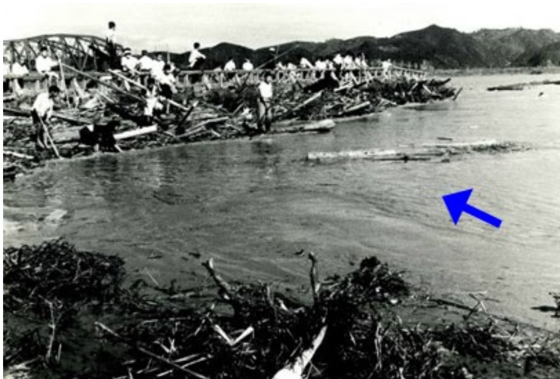
和歌山市南海橋の被害状況
