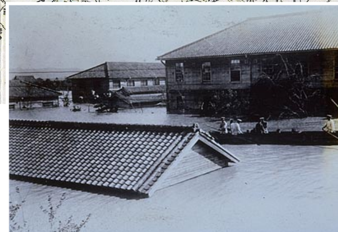
高槻市三島江兵隊舎の浸水状況
