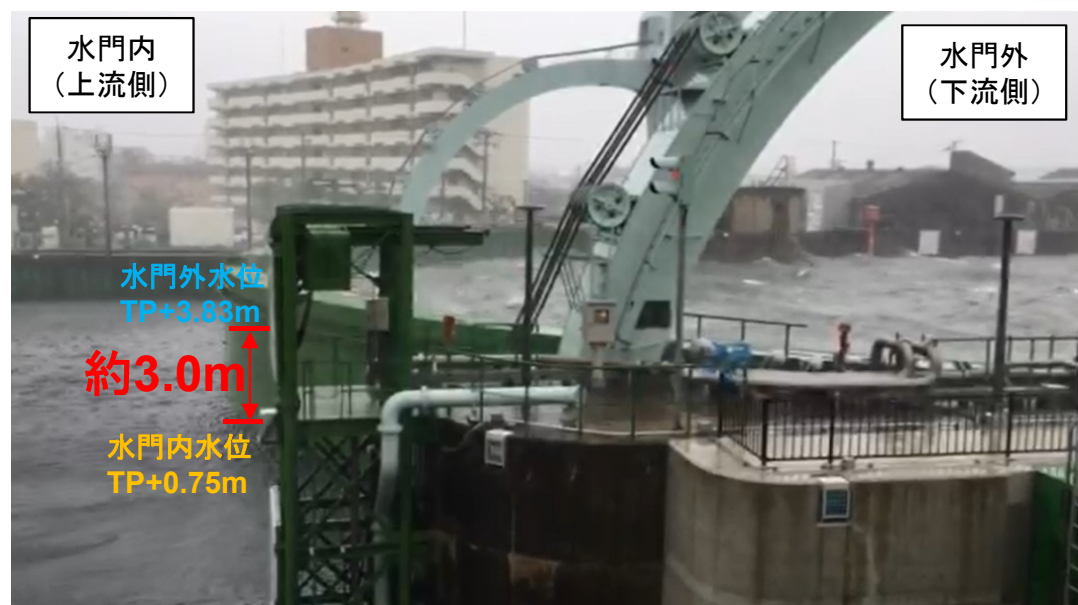
台風21号による高波来襲から市街地を守る木津川水門(平成30年9月4日)
