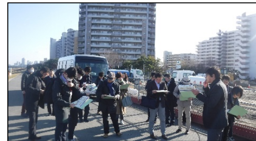
西島地区スーパー堤防施工地
