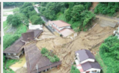
土砂災害の状況 ひた (大分県日田市)
