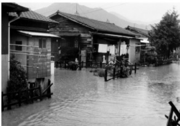
栗栖川沿川の浸水状況
