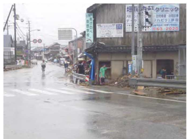
あづみ 安積橋下流浸水状況(宍粟市一宮町)
