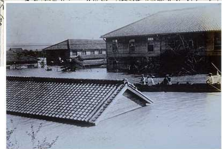
高槻市三島江兵隊舎の浸水状況
