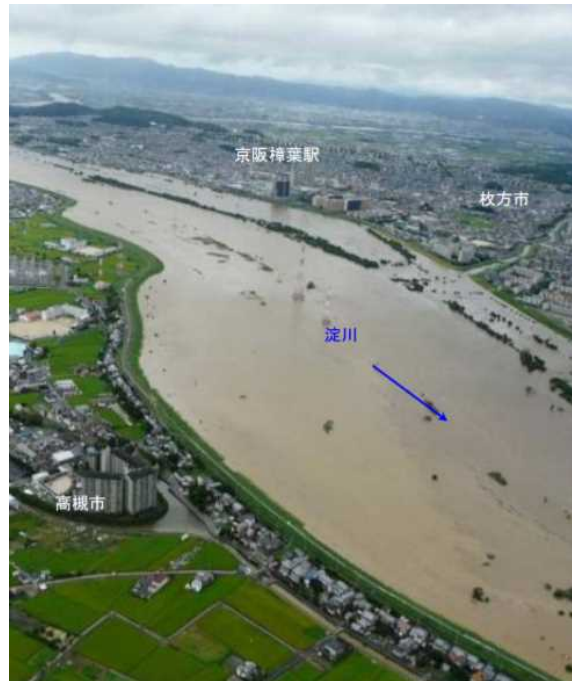
高槻市上空 枚方を望む(淀川本川水位ピーク付近)
