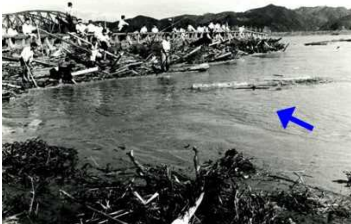
和歌山市南海橋の被害状況
