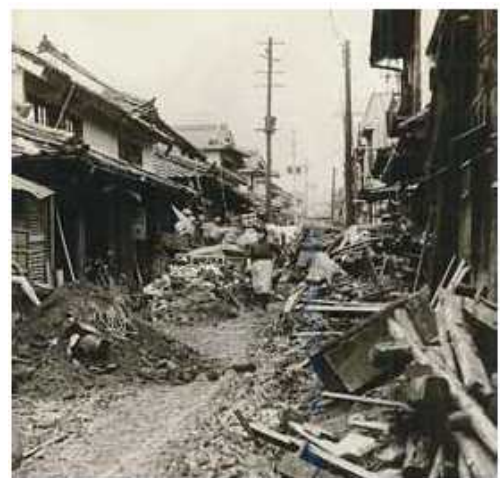
奈良県五條市の被害状況
