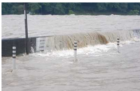
京都市右京区嵐山地先の浸水状況
