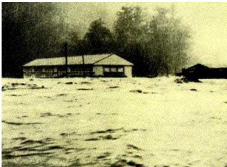
熊野川の氾濫状況(熊野川町付近)
