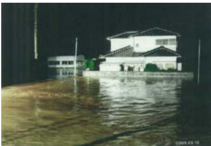
たい 宍粟市田井地区の浸水状況
