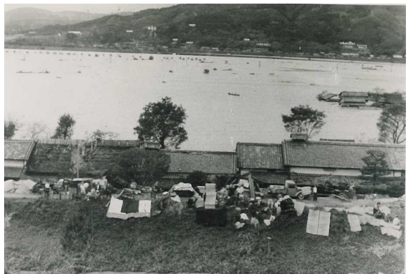
淀川右岸堤から高槻市内の浸水状況
