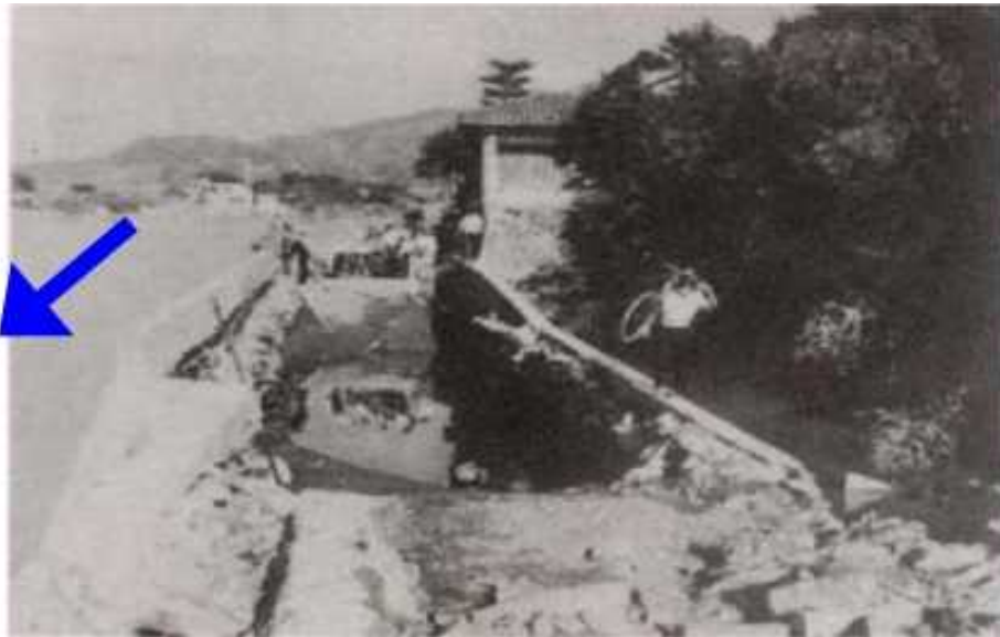
麻生津地区の被害状況 〔 溢水で大きく掘り取られた県道海南九度山線麻生津～竜門間 〕
