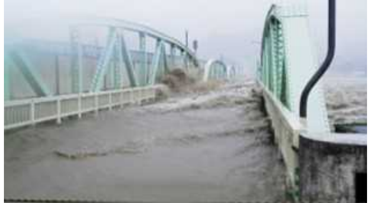
旧熊野川大橋からの越水(右岸)
