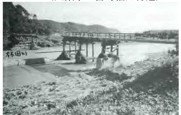
揖保川が土砂で埋没し流路が変わった状況 (宍粟市一宮町西深)
