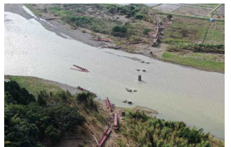
くま川鉄道 球磨川第4橋梁 橋梁流失 (熊本県球磨郡相良村-錦町)
