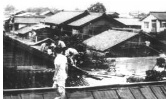
人吉市青井町の浸水状況
