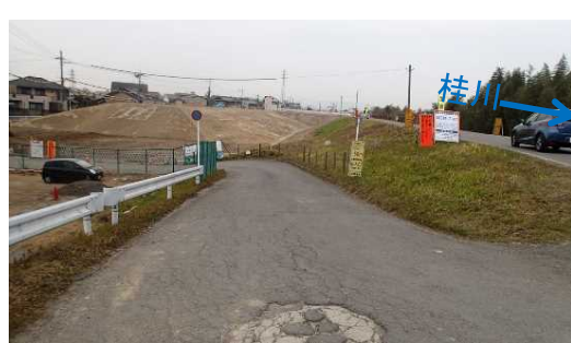
<施工完了後(H30.3)>
