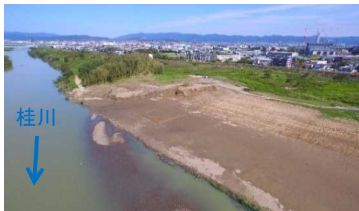
<施工完了後(H31.1)>
