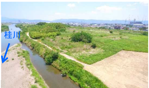
<工事実施前(H30.6)>
