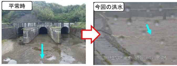
狩野川放水路により、約1,000m<sup>3</sup>/sの洪水を分派し本川の流量を低減
