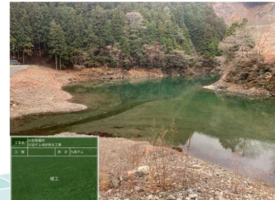
●No.12~13付近状況 堆積土砂除去後 (上流から撮影)
