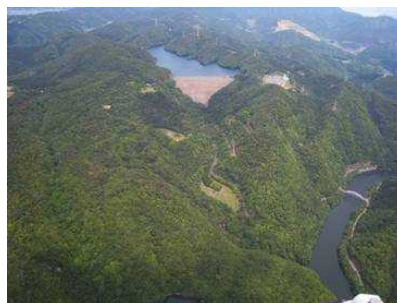
喜撰山ダム（揚水式発電の上池）
