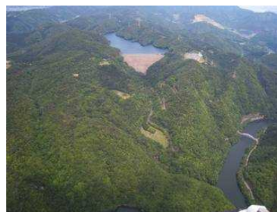
喜撰山ダム（揚水式発電の上池）
