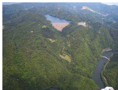
喜撰山ダム（揚水式発電の上池）
