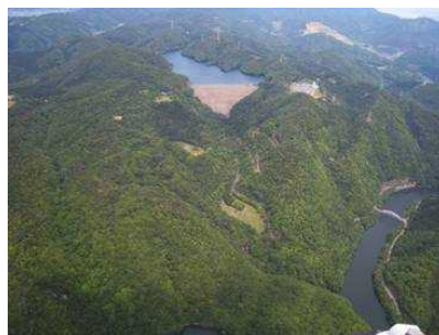
喜撰山ダム（揚水式発電の上池）
