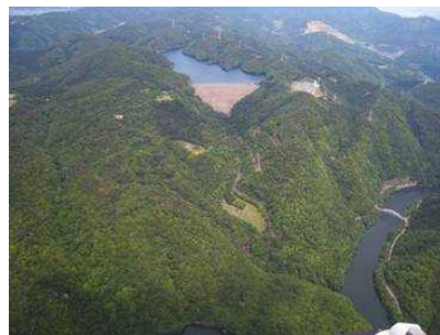
喜撰山ダム（揚水式発電の上池）
