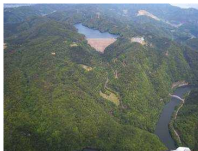
喜撰山ダム（揚水式発電の上池）
