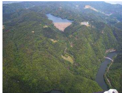
喜撰山ダム（揚水式発電の上池）
