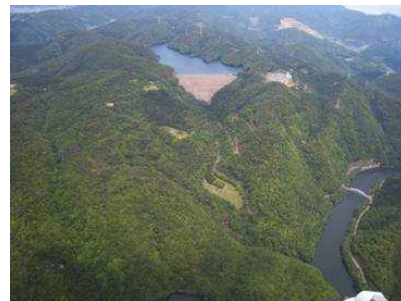
喜撰山ダム（揚水式発電の上池）
