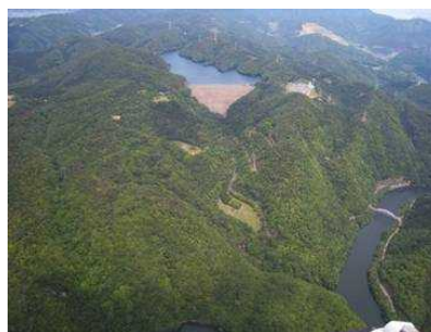
喜撰山ダム（揚水式発電の上池）
