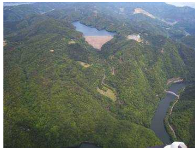
喜撰山ダム（揚水式発電の上池）
