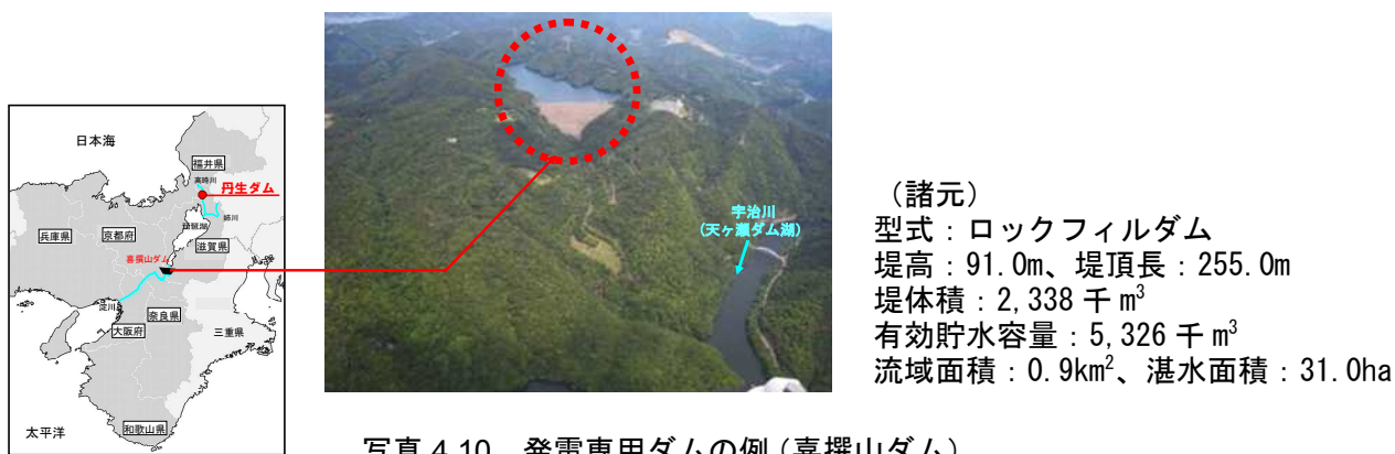
写真 4.10 発電専用ダムの例（喜撰山ダム）
