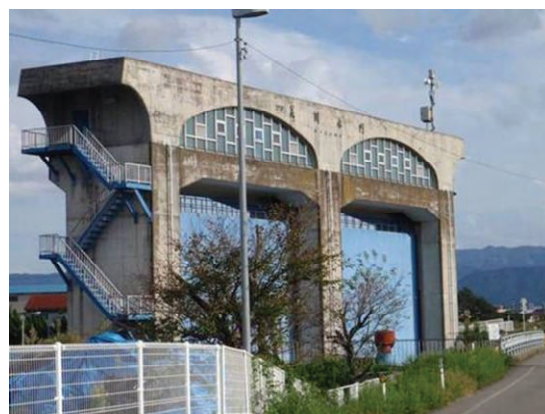
荒川水門(足羽川右岸4.6k付近)
