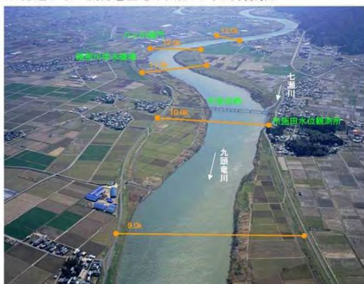
九頭竜川の河道内の樹木の状況
