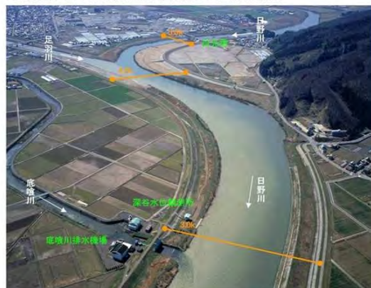
日野川の河道内の樹木の状況
