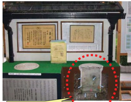
雨水浸透ます断面
