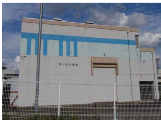
荒川排水機場(足羽川右岸4.6k付近)
