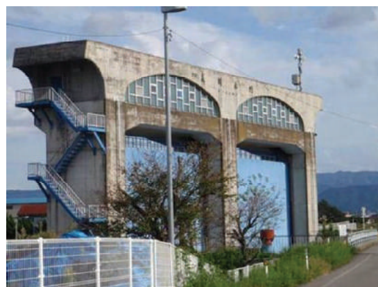
荒川水門(足羽川右岸4.6k付近)
