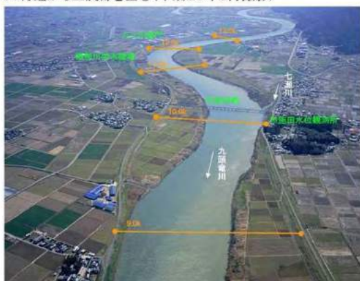
九頭竜川の河道内の樹木の状況
