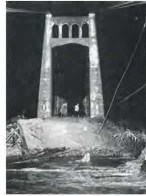
鳴鹿橋の流出
