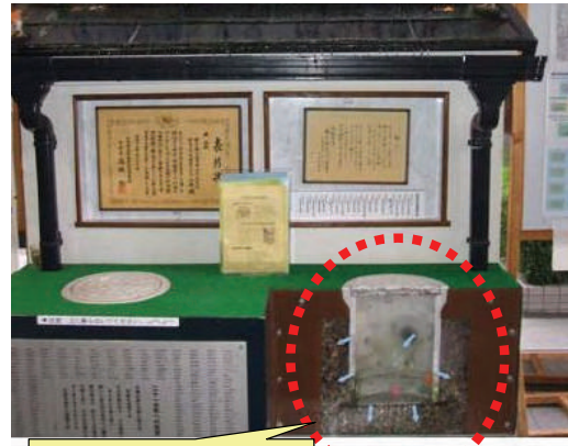
雨水浸透ます断面
