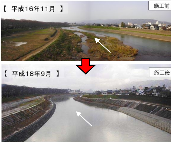
足羽川の河道内の樹木の状況 (河床掘削の前後)
