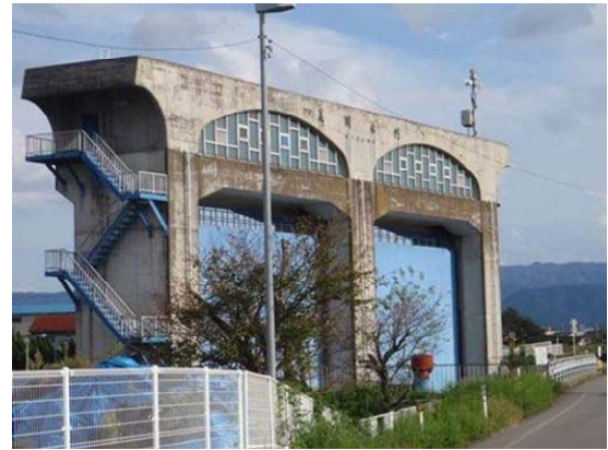
荒川水門(足羽川右岸4.6k付近)
