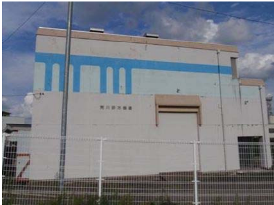
荒川排水機場(足羽川右岸4.6k付近)
