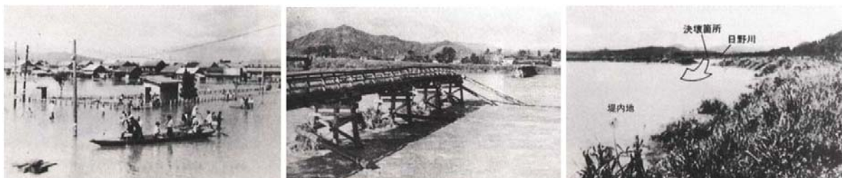
福井市花月町付近 西公園付近の浸水状況
