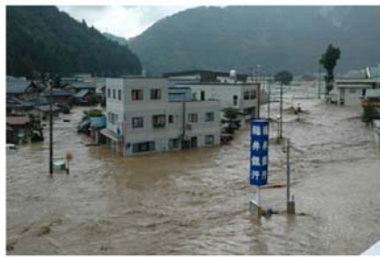
美山町役場付近の浸水状況 （美山町（現福井市）朝谷島）
