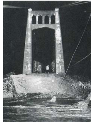
鳴鹿橋の流出
