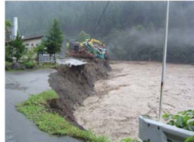
河岸侵食状況 （池田町持越）
