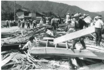
上志比村(現永平寺町)の被災状況
