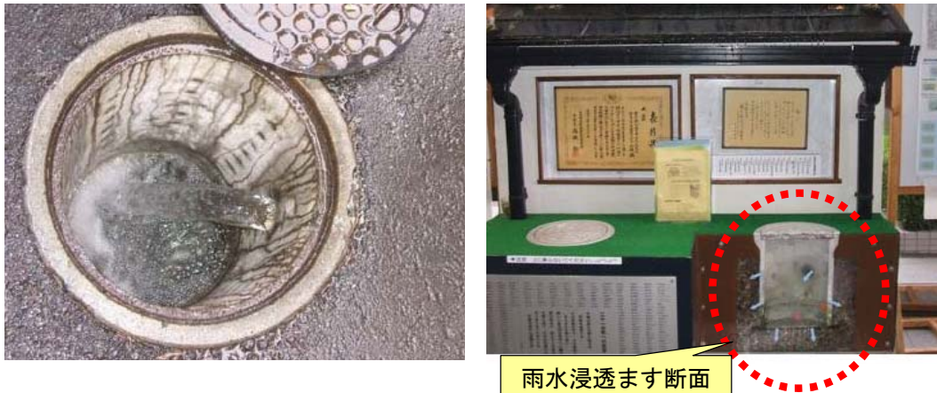
雨水浸透ますの例
