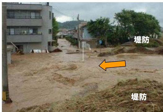
平成16年7月福井豪雨 足羽川の堤防の決壊状況(福井市春日)
