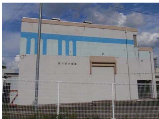
荒川排水機場(足羽川右岸4.6k付近)
