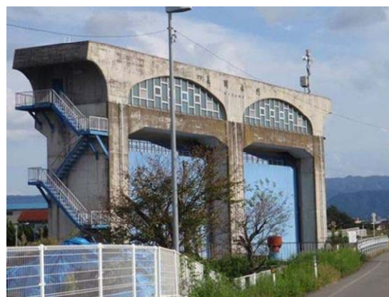
荒川水門(足羽川右岸4.6k付近)
