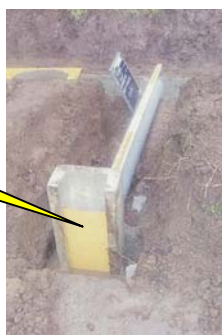
落水口の改造の例
