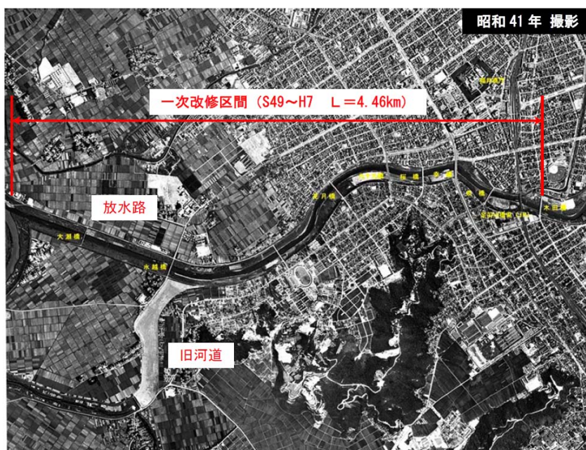
図 2-23 足羽川（下流の放水路開削区間）
