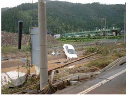
足羽堰堤付近左岸堤内地の被災状況 （福井市安波賀中島）
