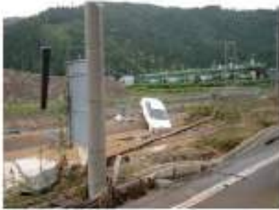
足羽堰埋付近左岸堰内地の被災状況 （福井市安波賀中島）
