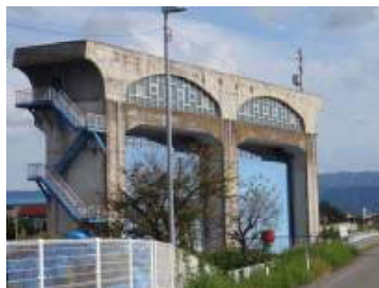
荒川水門(足羽川右岸4.6k付近)
