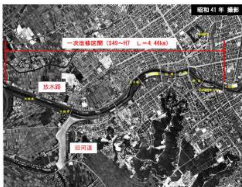
図 2-23 足羽川（下流の放水路開削区間）
