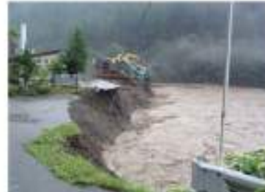
河岸侵食状況 （池田町持越）
