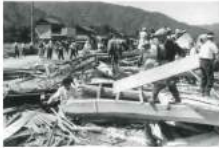
上志比村(現永平寺町)の被災状況
