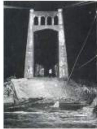
鳴鹿橋の流出
