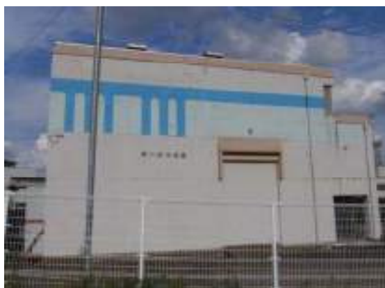
荒川排水機場(足羽川右岸4.6k付近)
