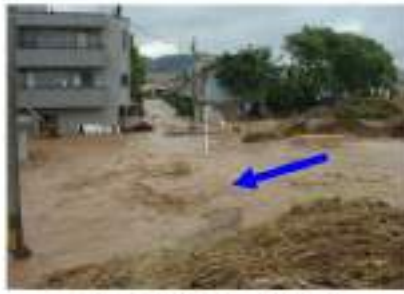
破堤部の状況（福井市春日）
