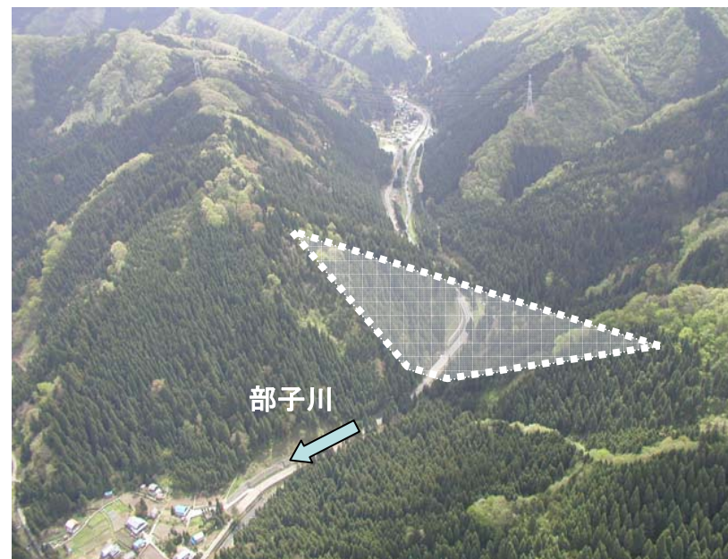
足羽川ダム(建設予定地)
