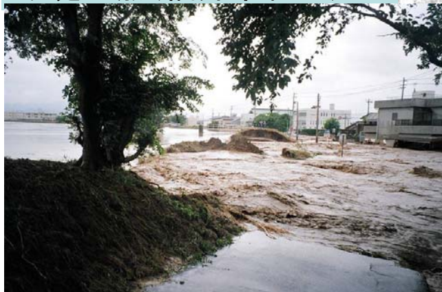
破堤地点（福井市春日）
