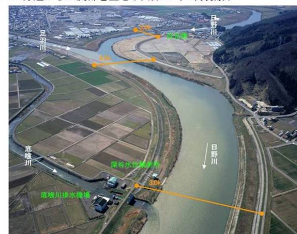
日野川の河道内の樹木の状況
