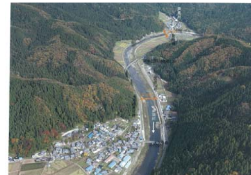
足羽川上流 21.0k付近
