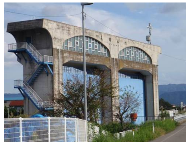
荒川水門(足羽川右岸4.6k付近)
