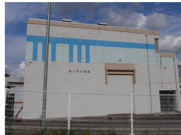
荒川排水機場(足羽川右岸4.6k付近)
