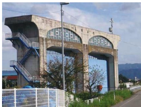
荒川水門(足羽川右岸4.6k付近)
