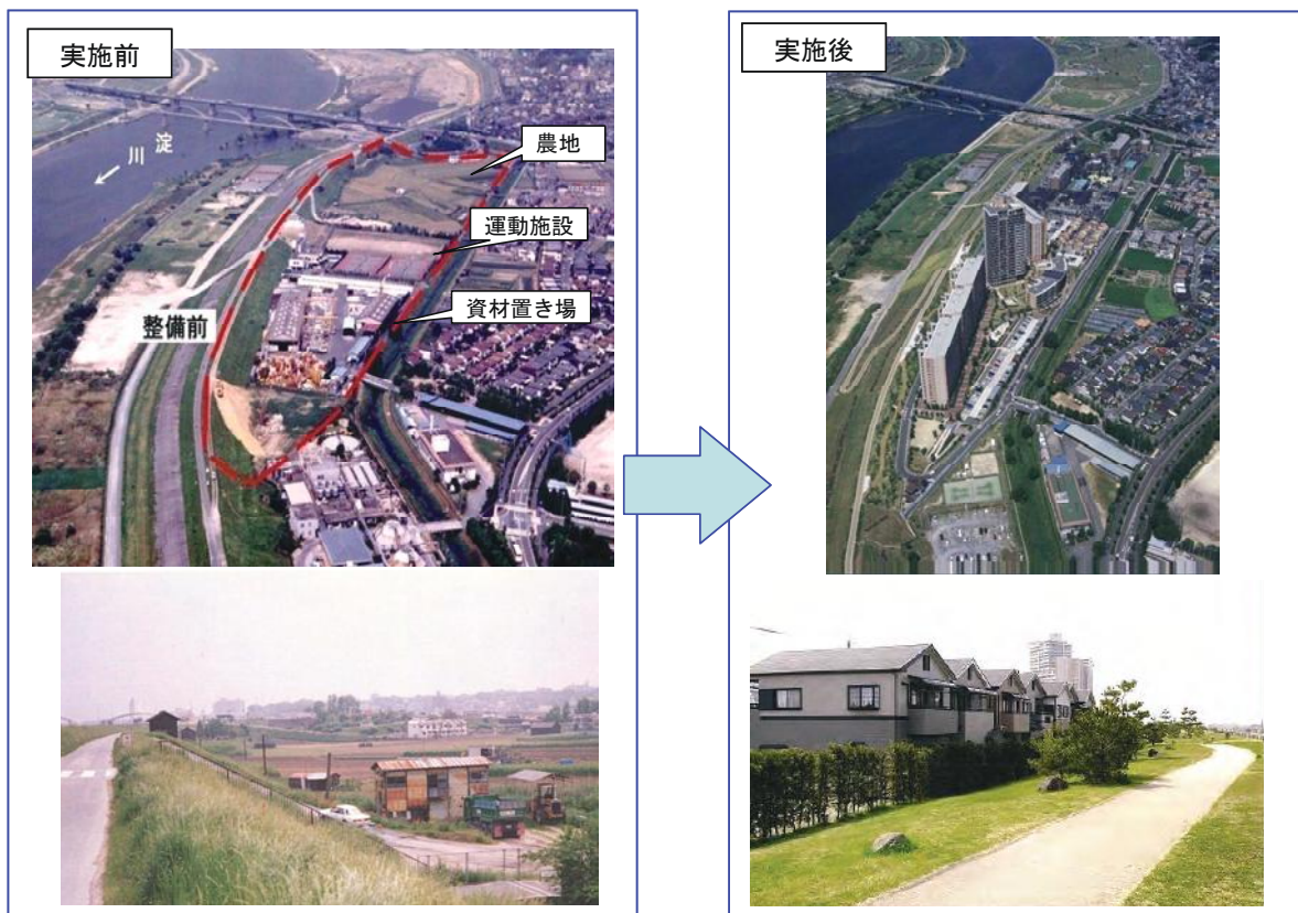
高規格堤防の実施例(淀川・伊加賀西地区／大阪府)
