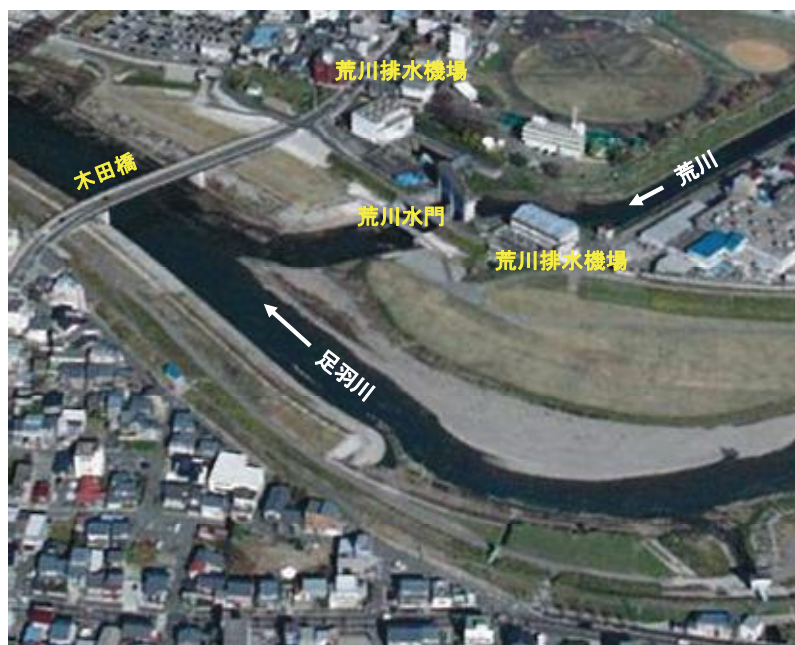
足羽川と支川荒川との合流点の状況(足羽川右岸4.6k付近)
