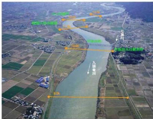
九頭竜川の河道内の樹木の状況
