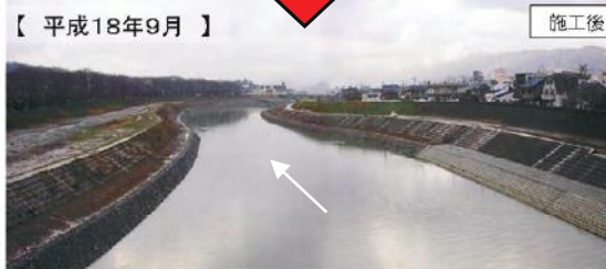
足羽川の河道内の樹木の状況 (河床掘削の前後)
