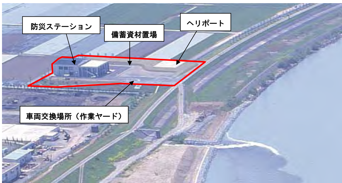
図 2-30 九頭竜川 つちほし 土橋地区河川防災ステーション
