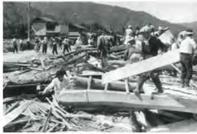
上志比村(現永平寺町)の被災状況
