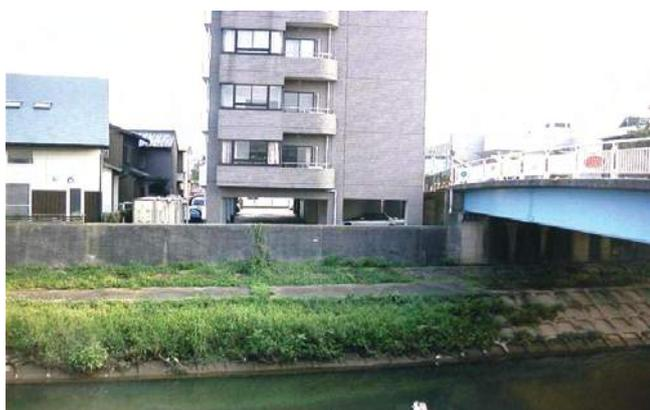
1階を駐車場だけにし、2階以上を住居にするピロティ建築などにより、洪水時の被害を軽減します。
