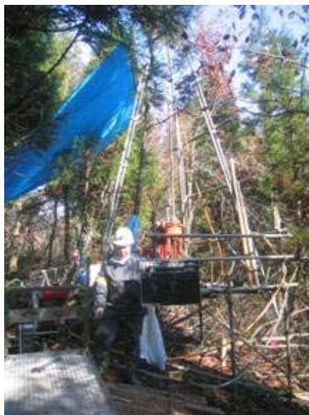
地質調査状況写真
