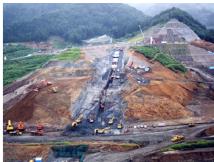
基礎掘削（他ダム事例）
