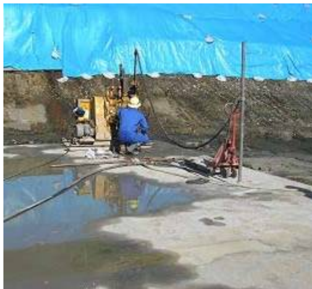
グラウチング状況 (他ダム事例)
