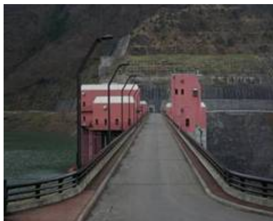
照明設備写真（他ダム事例）
