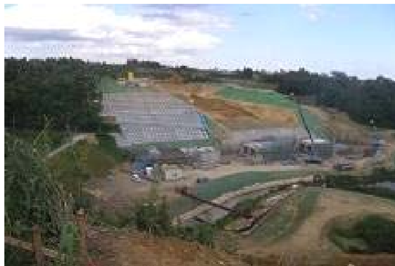
法面工 (他ダム事例)
