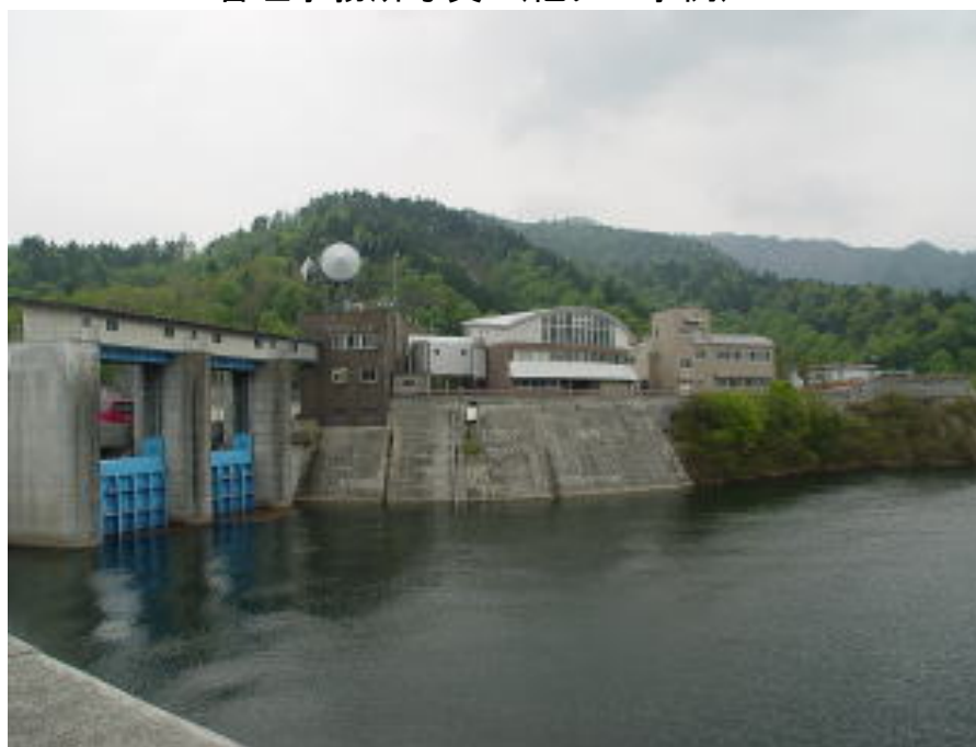
管理事務所写真（他ダム事例）
