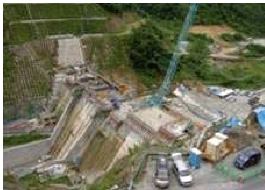
堤体工（他ダム事例）
