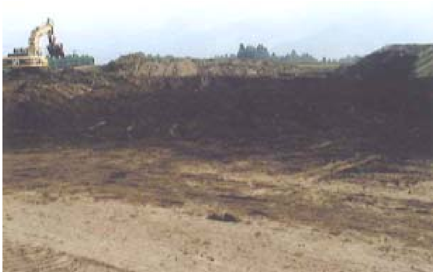
建設発生土処理（他ダム事例）
