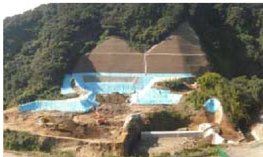
法面工（他ダム事例）
