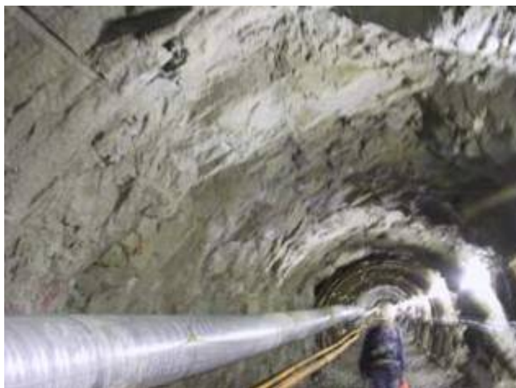
トンネル掘削 (他事例)
