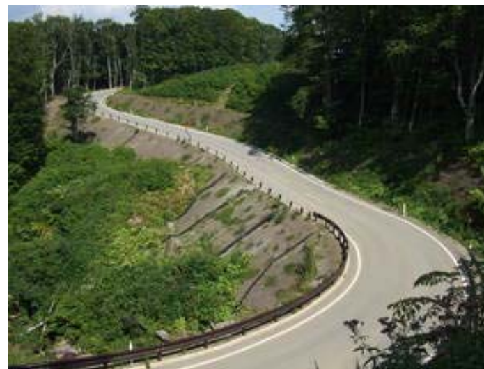
工事用道路写真 (他ダム事例)
