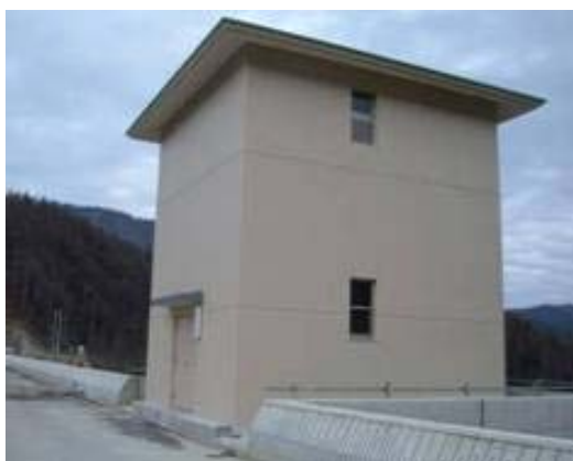
昇降設備写真（他ダム事例）
