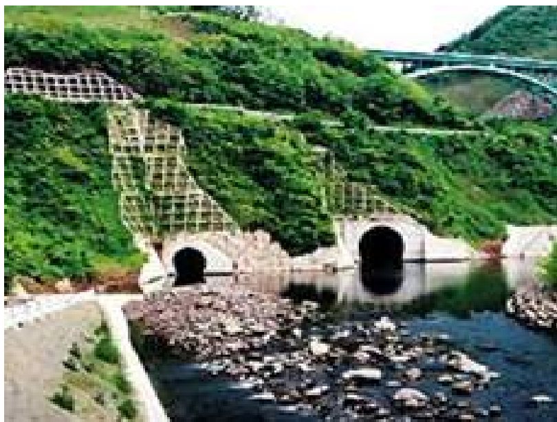
仮排水トンネル (他ダム事例)
