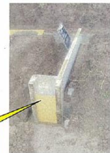
水田貯留用の堰板の交換。
