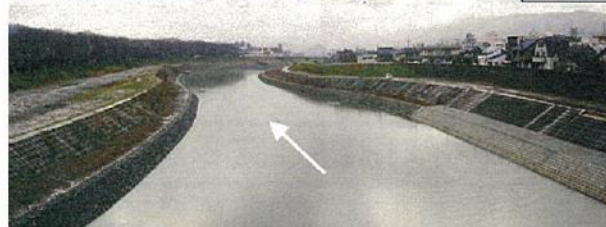
足羽川の河道内の樹木の状況（河床掘削の前後）
