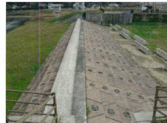
注) 写真は、「決壊しない堤防」の構造のイメージとして、遊水地の越流堤を示したもの。
