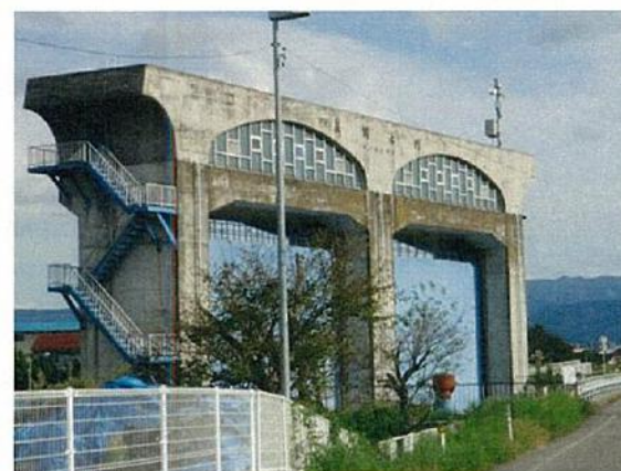
荒川水門 (足羽川右岸4.6k付近)
