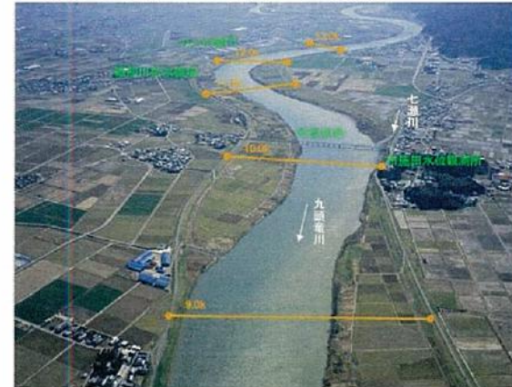
九頭竜川の河道内の樹木の状況
