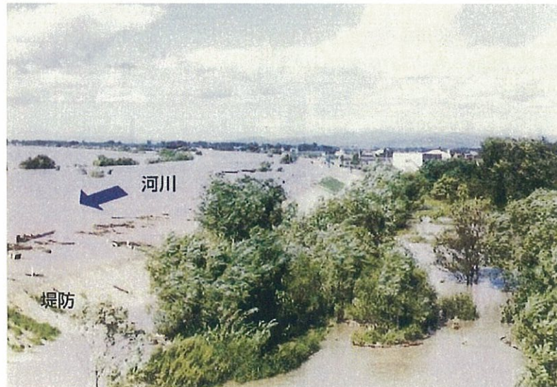
出典：堤防に沿った樹林帯の手引き
