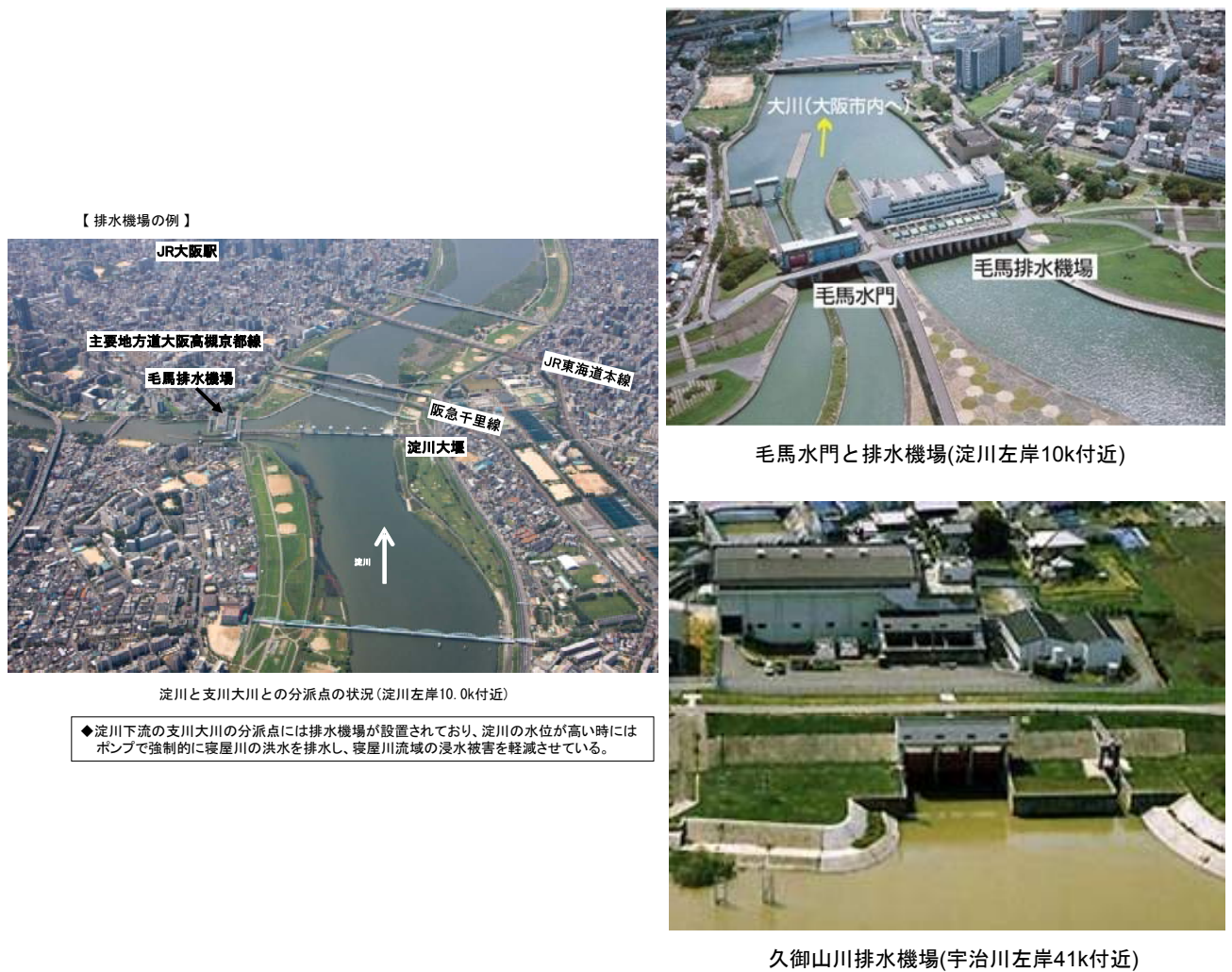
図 4.2-19 毛馬排水機場
