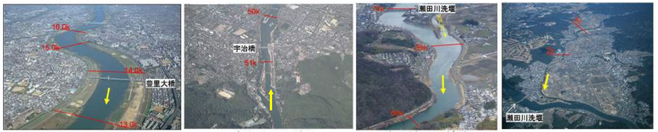
① 淀川 (大臣管理区間) 13~16k 付近 ② 宇治川 (大臣管理区間) 50~52k 付近 ③ 瀬田川 (大臣管理区間) 68~70k 付近 ④ 大戸川 (滋賀県管理区間) 1~3k 付近
