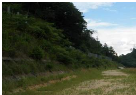
写真 3.2-5 在来種を用いた法面吹き付けによる回復状況（3年経過）
