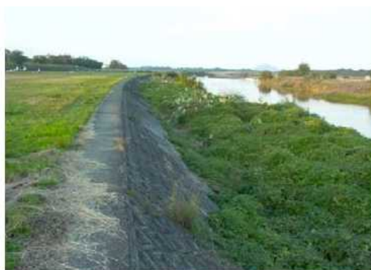
写真 2.3-3 コンクリート護岸
