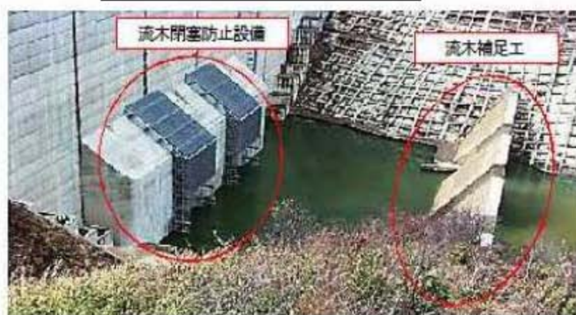
流木止め設備（流木閉塞防止設備+流木補足工）
