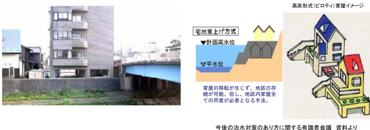
図 4.2-30 ピロティ構造の事例
