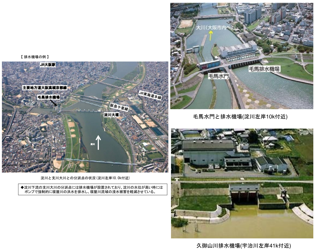
図 4.2-19 毛馬排水機場
