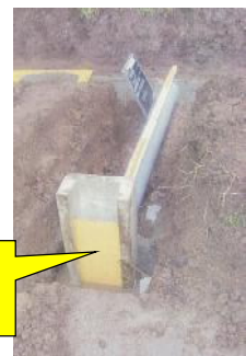
落水口の改造の例
