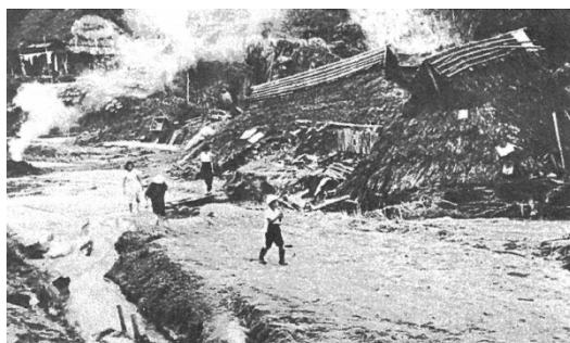
写真 2.2-1 甲賀市信楽町多羅尾村の家屋被害
