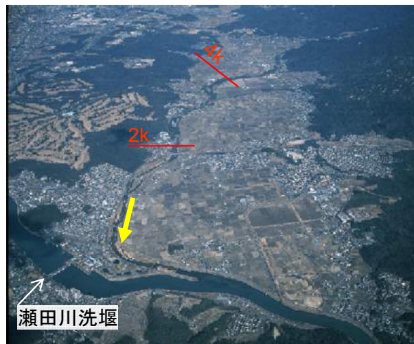
大戸川（滋賀県管理区間）0～4k 付近
