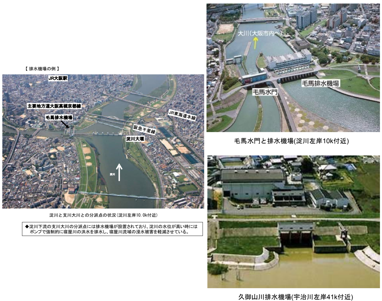
図 4.2-19 毛馬排水機場
