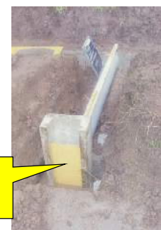
落水口の改造の例
