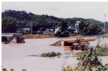
写真 2.2-4 大津市石居の橋梁流出
