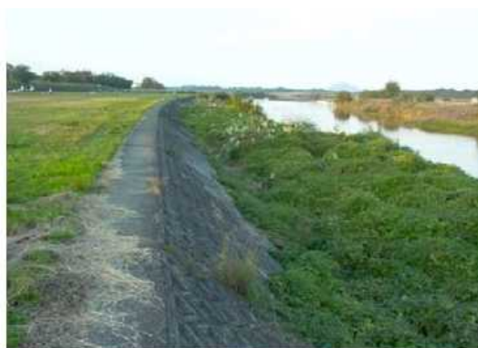
写真 2.3-3 コンクリート護岸
