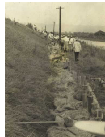
写真 2.2-3 京都府久御山町の堤防漏水・裏法崩れ
