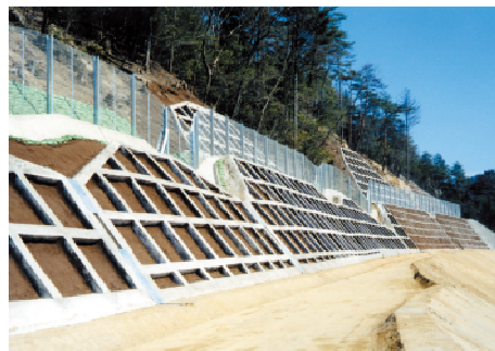
写真 3.2-4 在来種を用いた法面吹き付けによる回復状況（施工直後）
