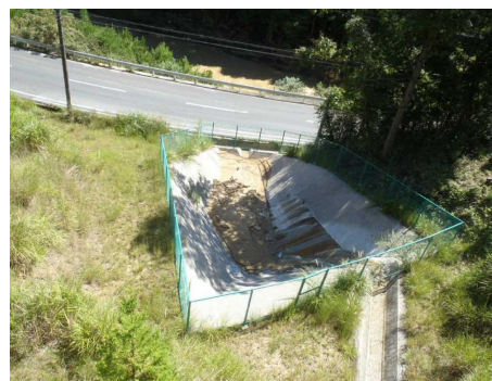
写真 3.2-1 沈砂池の設置状況
