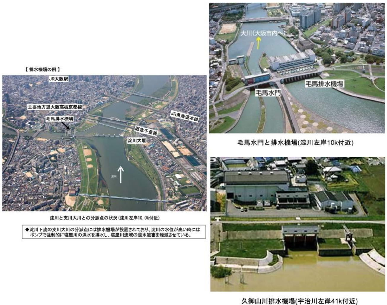
図 4.2-19 毛馬排水機場
