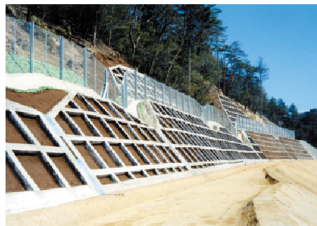
写真 3.2-4 在来種を用いた法面吹き付けによる回復状況（施工直後）
