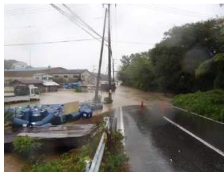
写真 2.2-7 大津市石居の浸水被害
