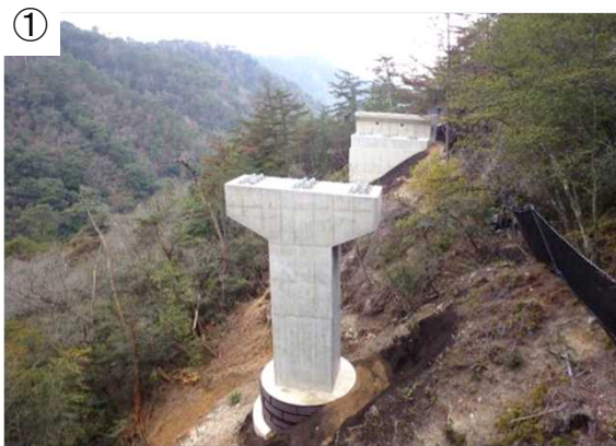
桐生辻トンネルから下流を望む
