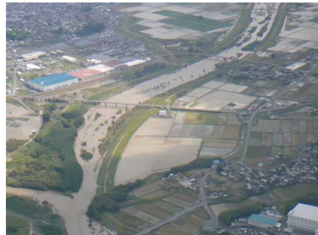
伊賀上野地区浸水状況
