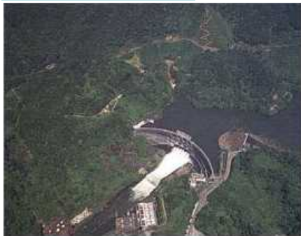
天ヶ瀬ダム S39完成 (F,W,P)
