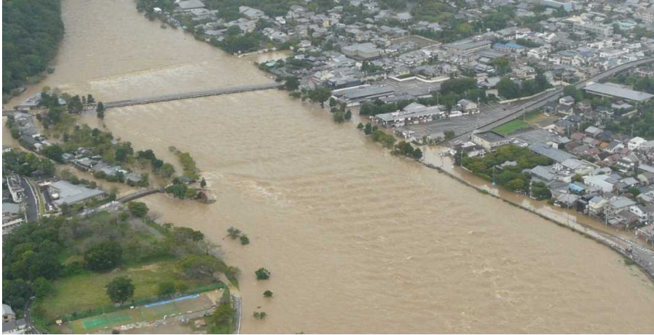
京都市嵐山浸水状況
