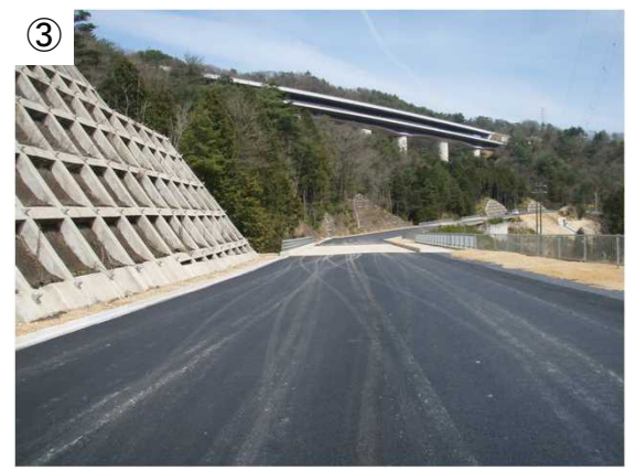
42号橋付近から上流を望む
