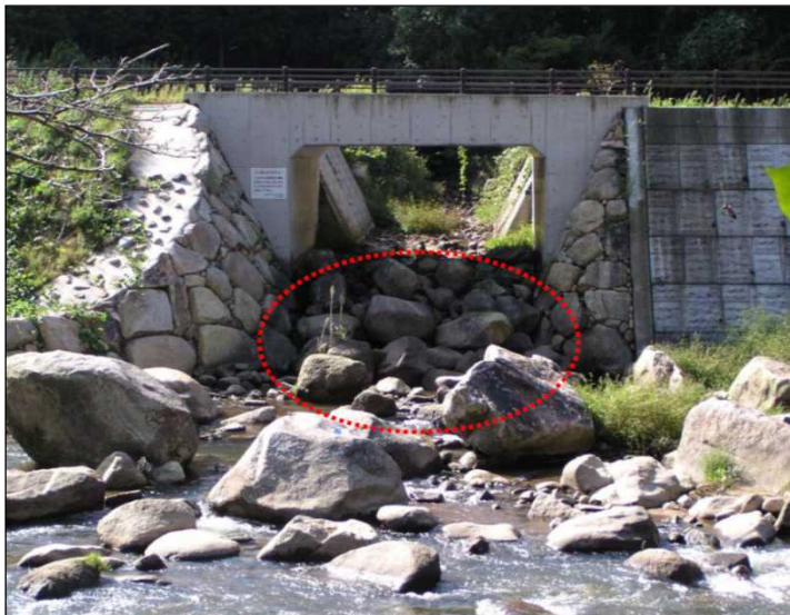
動物の移動経路に配慮して ボックスカルバート内に巨石を設置
