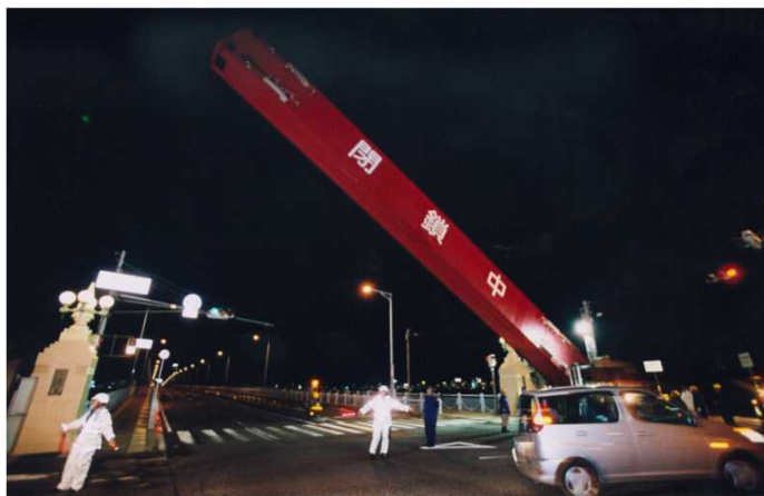
H16.8台風16号時の淀川陸閘閉鎖状況
