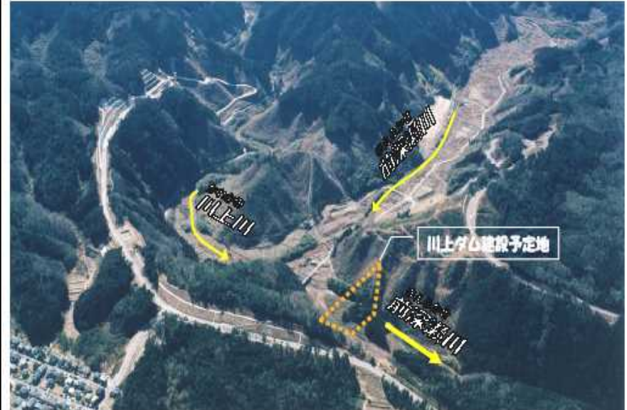
川上ダム建設予定地
