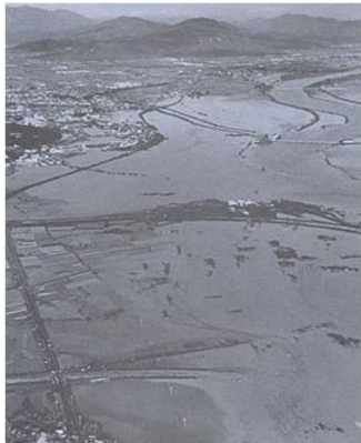
昭和47年 台風20号 亀岡市
